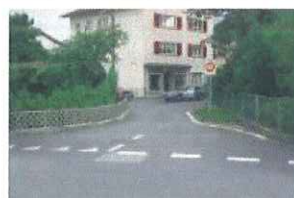
Torelement zu Beginn der Tempo-30-Zone
