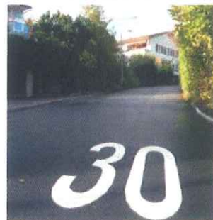
Wiederholt Tempo-30-Signete auf der Fahrbahn
